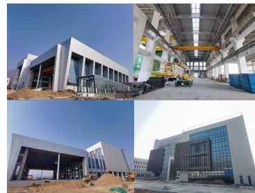
城市安全重大事故防控技术支撑基地施工现场
