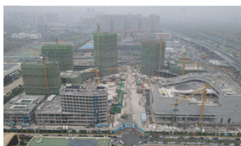
合肥公共安全研究院二期建设现场
